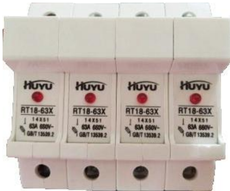
图1 RT18有填料封闭管式熔断器
